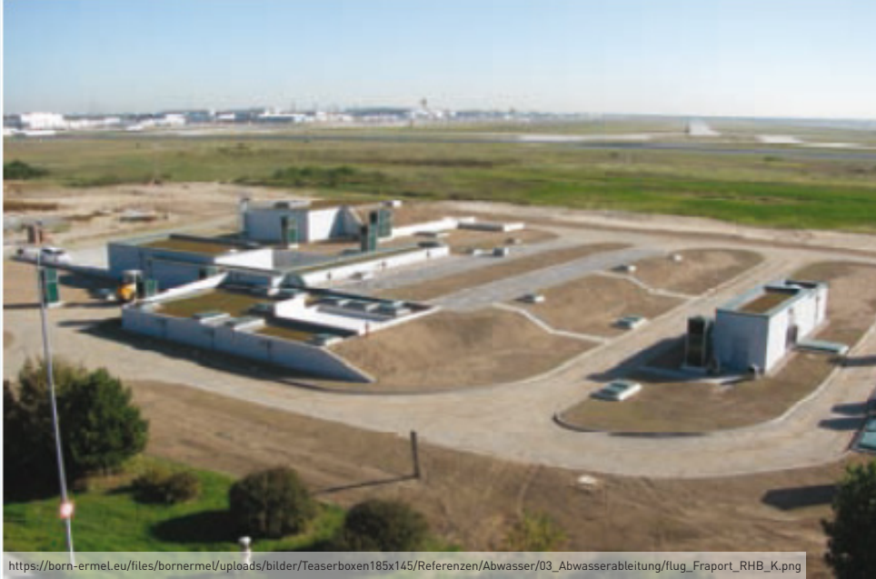
Frankfurt Uluslararası Havalimanı Yağmur Suyu Tutma Havuzu
